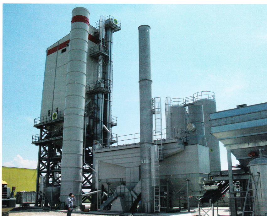
Impianto produttivo asfalti (cortesia di Bernardi Impianti)
